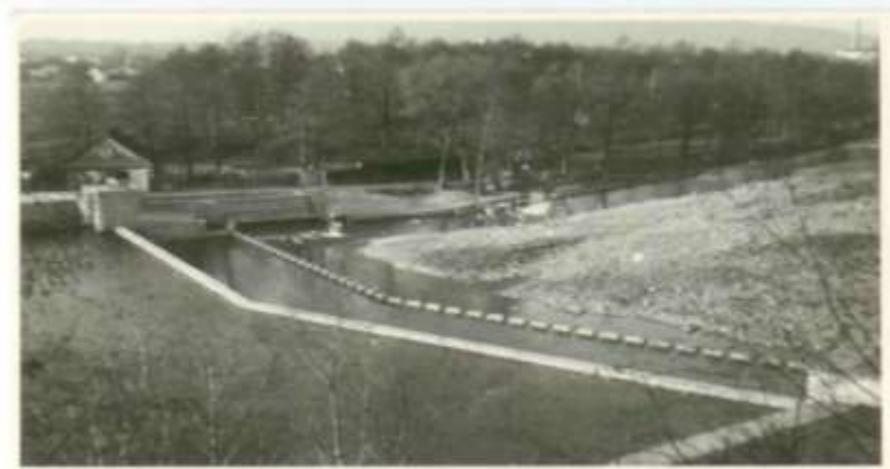
Foto 1. Jaz na Sole pod Małą Górą – przebudowany w latach 1947-1950, konstrukcje drewnianą zastąpiono murowaną z kamienia (fot.KN).
